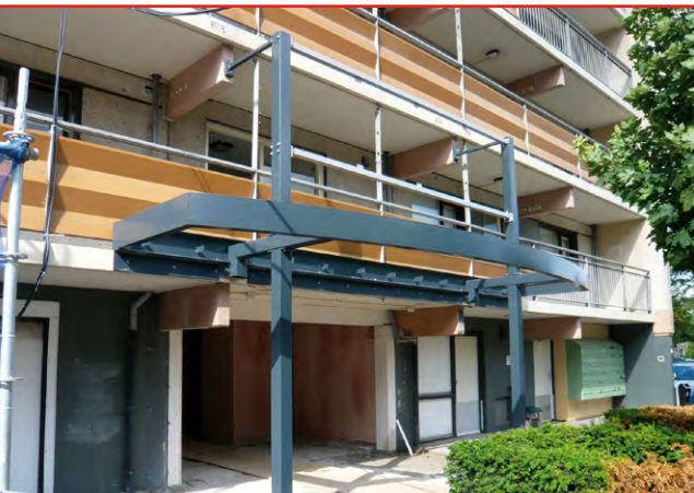
stalen luifelportaal geplaatst —
